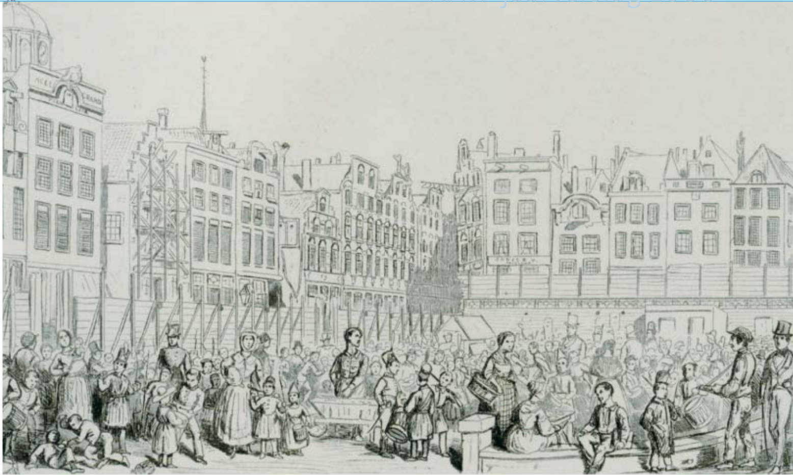
J. van Clasterwijk Bruijn, Behulpbeurs op het Rokin . Tekening, ca. 1836-1848. De behulpbeurs was een noodoplossing op het terrein van de afgebroken beurs van Hendrick de Keyzer in afwachting op de opening van de Beurs van Zocher.
